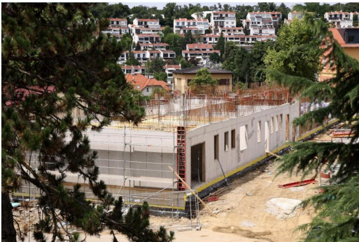
Paviljon II tijekom obnove:
